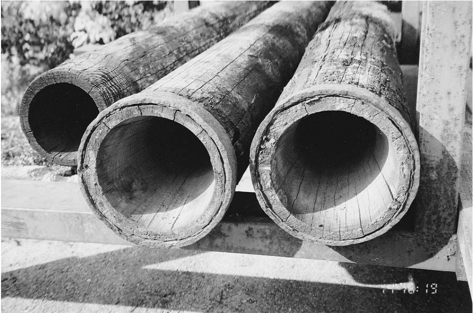
Abb. 8: Historische Holzröhren der Sole-Pipeline („Strähm“) zwischen Hallstatt und Ebensee, ausgestellt vor dem Gasthaus Steegwirt in Bad Goisern (Foto: DRUCKENTHNER 2007)
